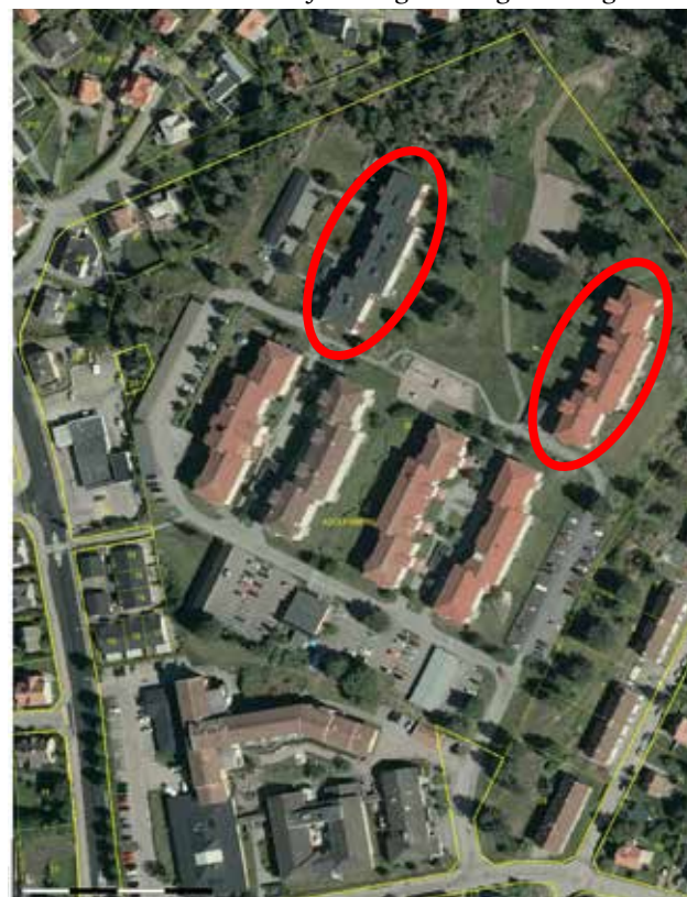
I ortofoto ovan (utdrag ur Lantmäteriets karttjänst KSO med fastigheter gulmarkerade) rödmarkeras byggnaderna som omfattas av planändringen. Byggnaden i norr (till vänster av de två markerade) är Andréegatan 13 och byggnaden österut (till höger av de två markerade) utgör Andréegatan 1.
